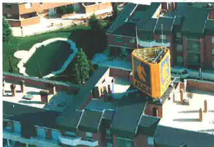
Fig. 17 Ejemplo de estructura sobre edificio.
