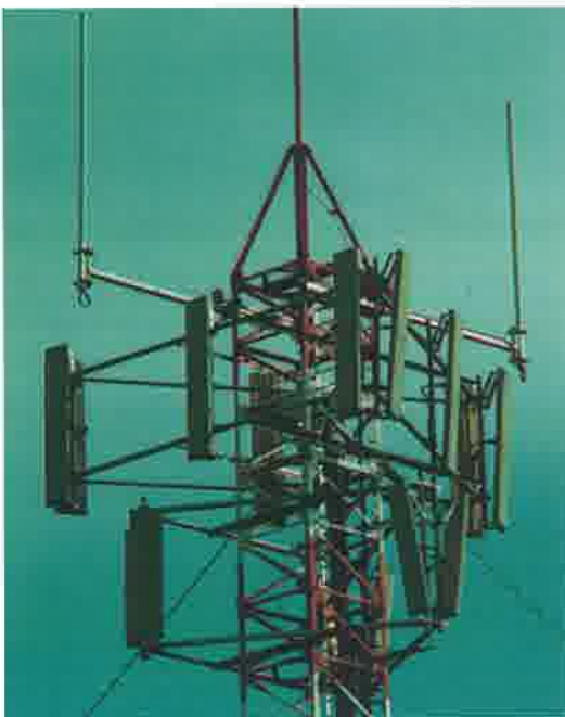
Fig. 15. Ejemplo de diversidad espacial y diversidad en polarización.
