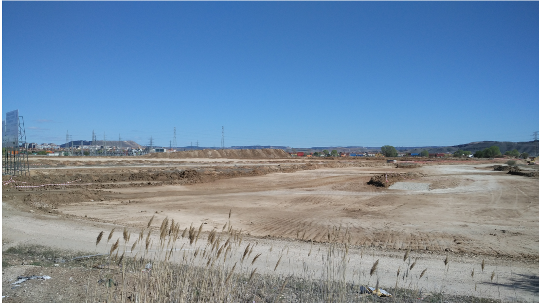
Estado de movimiento de tierras de las obras de la urbanización del ámbito
