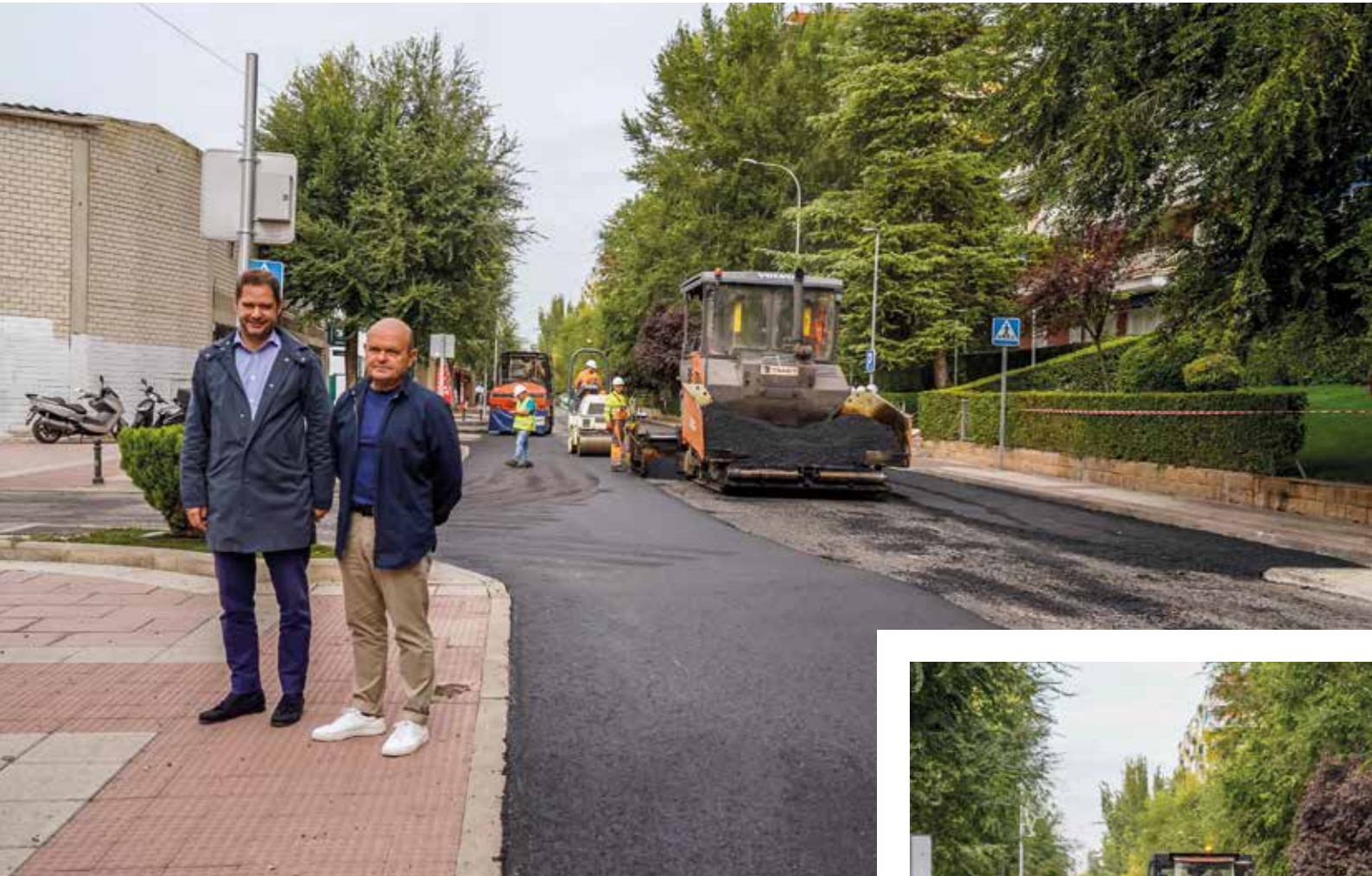
El alcalde, Ignacio Vázquez, y el concejal de Obras, Valeriano Díaz, comprobando los trabajos de asfaltado
