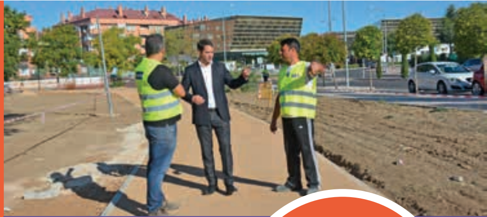
El alcalde visitó las obras en la c/ Joaquín Blume
